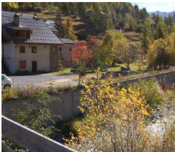
Endiguement en béton - Source : PPRN Saint-Véran
