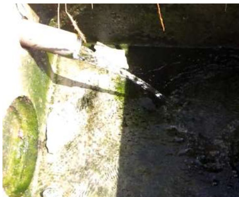
Arrivée d'eau claire parasite sur le regard vers les sanitaires (à gauche, n°4) et arrivée du mauvais branchement (n°2)
