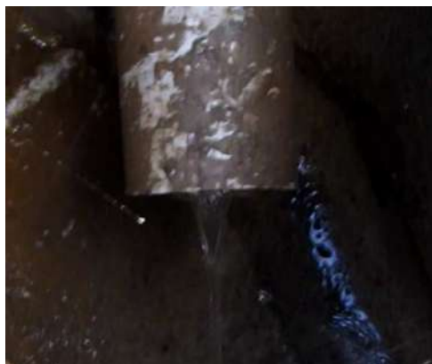
Arrivée d'eau claire parasite dans le regard depuis la source (n°7) et infiltration dans le regard (n°3)
