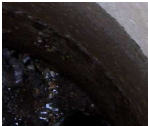
Arrivée d'eau claire parasite dans le regard depuis la source (n°7) et infiltration dans le regard (n°3)
