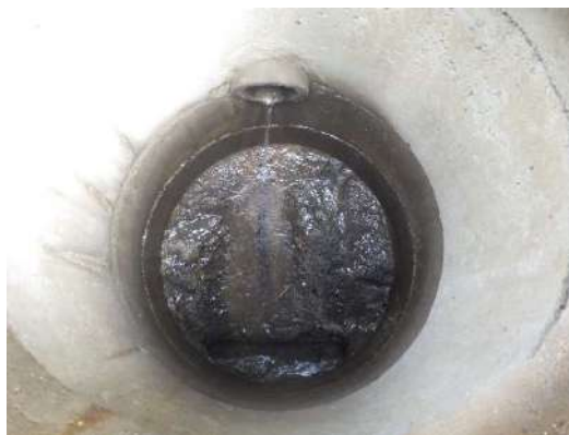
Arrivée d'eau claire parasite sur le regard vers les sanitaires (à gauche, n°4) et arrivée du mauvais branchement (n°2)
