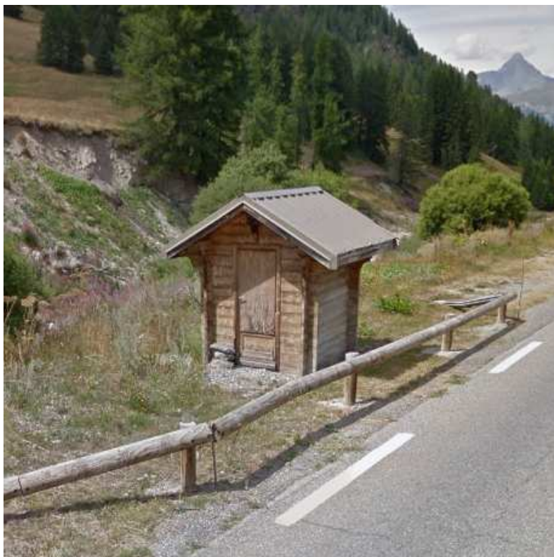
Figure 44 : Vue extérieure du canal de comptage de Saint-Véran
