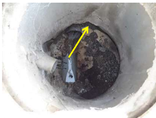
Casses et raccordement non étanche
