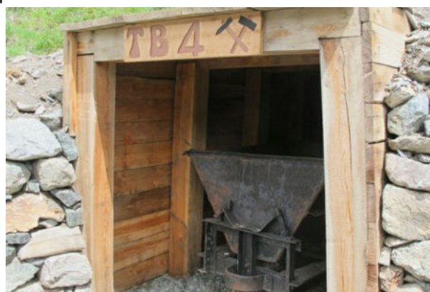
L'entrée du travers-banc 4 rénové
