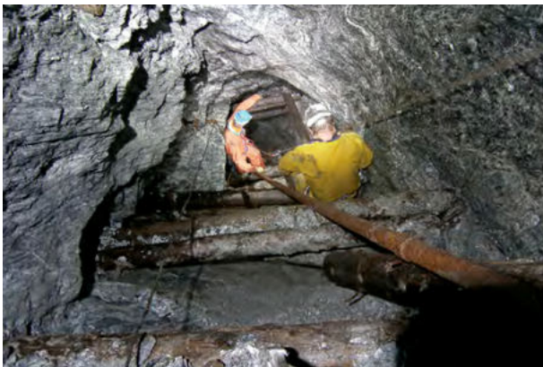
Zone où l'escalier en bois s'est décroché
