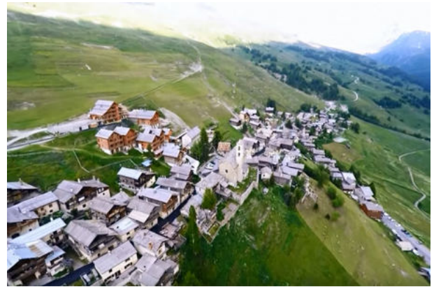
La réfection de la rue vue du ciel
